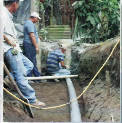
Colocación de tubería de drenaje nueva en nuevo Texcuaco
