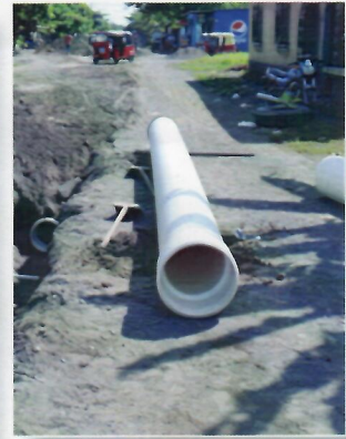
Colocación de tubería de drenaje nueva en Nuevo Texcuaco
