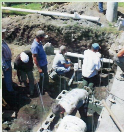
Colocación de tubería de drenaje con el fin de evitar inundamientos en el área del Básico y colonias aledañas
