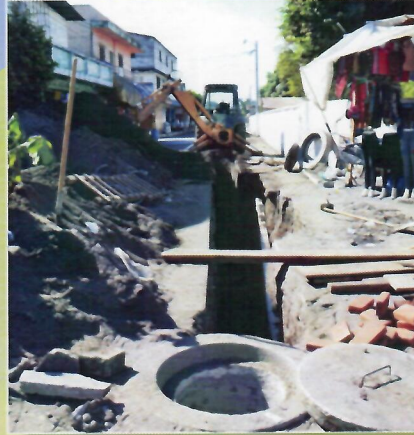
Introducción de tubería de drenaje del mercado a Callejón las Vegas
