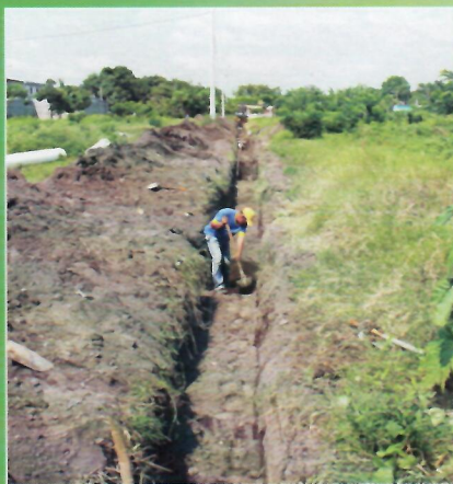
Colocación de tubería de drenaje con el fin de evitar inundamientos en el área del Básico y colonias aledañas
