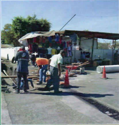
Introducción de tubería de drenaje del mercado a Callejón las Vegas
